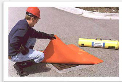
Bảo vệ cống rãnh thoát nước mưa.
