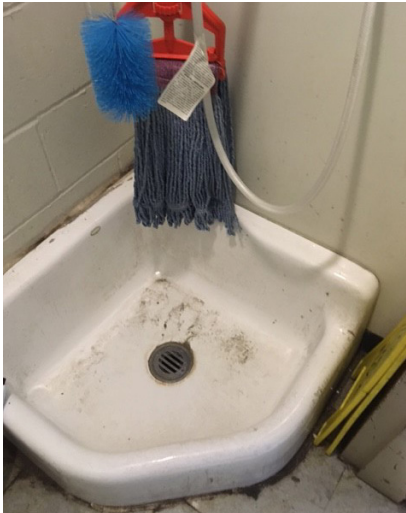
El drenaje sanitario fluye a la planta de tratamiento.
